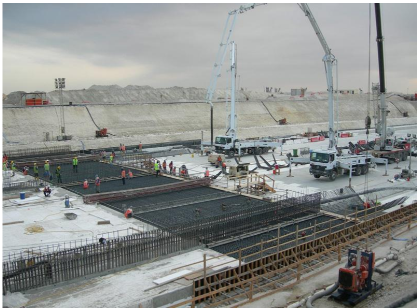
中水电机场项目
